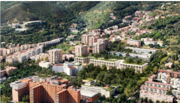
Hospital Vall d'Hebron, VHIR, VHIO Projecte: 2018-2022
